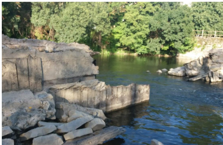
3 FOTOGRAFÍA DEL AZUD DE SANTA ENGRACIA. PAMPLONA
